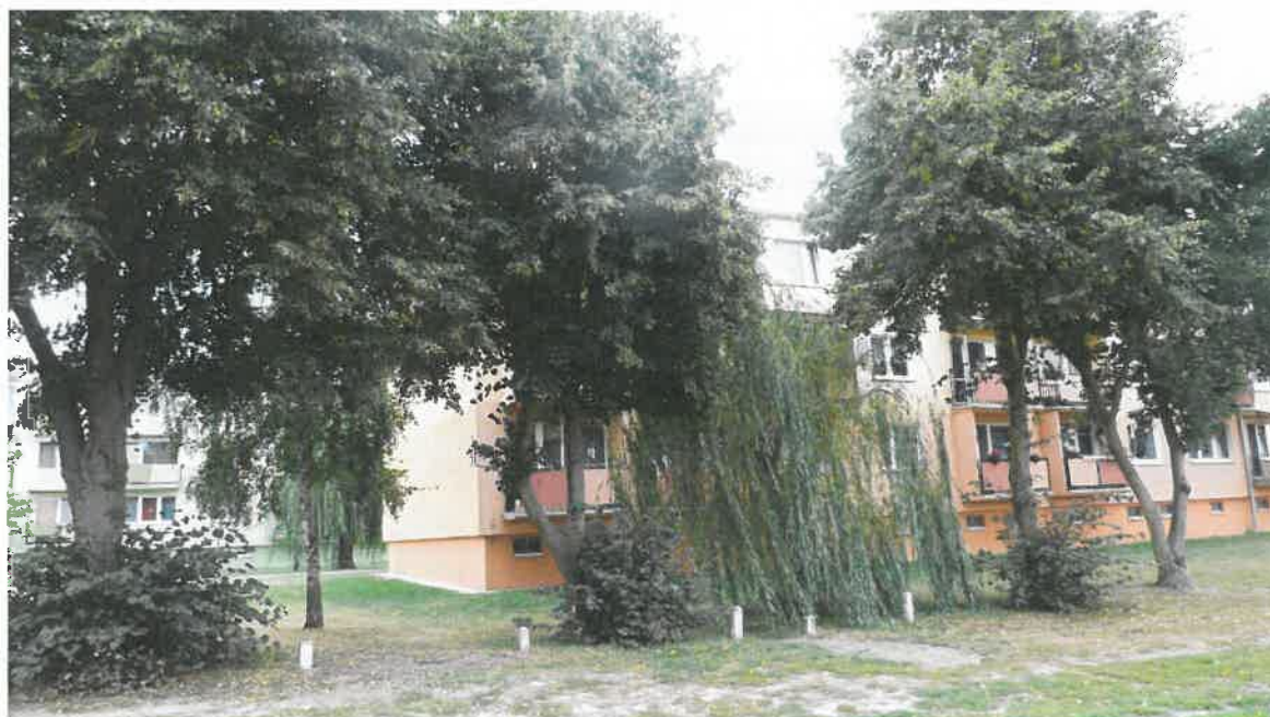
Rysunek 8. Zabudowa mieszkaniowa wielorodzinna ul. Ogrody
