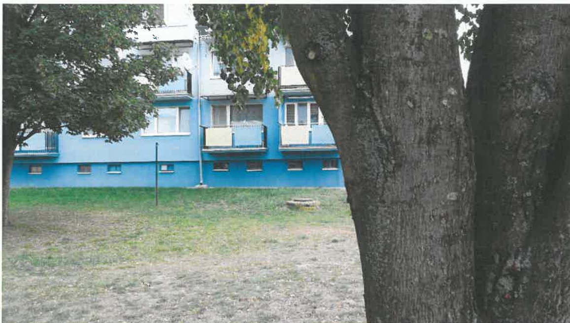
Rysunek 7. Zabudowa mieszkaniowa wielorodzinna ul. Ogrody
